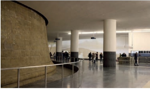
Fig. 2. Metropolitana di Napoli, stazione Municipio-Porto. A sinistra parte del torrione dell'Incoronata di epoca vicereale restaurato e lasciato in bella vista nello spazio della stazione (Progettisti Alvaro Siza Viera ed Edoardo de Souto de Moura).
